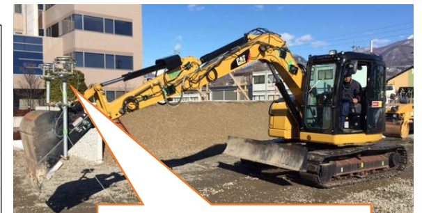
バックホウ先端に GNSSアンテナを設置 38
